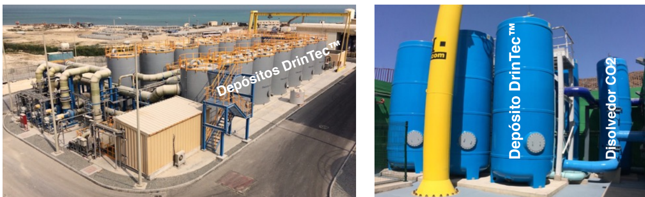
Fig. 1.1: Algunos aspectos de las diferentes instalaciones de remineralización de DrinTec™
