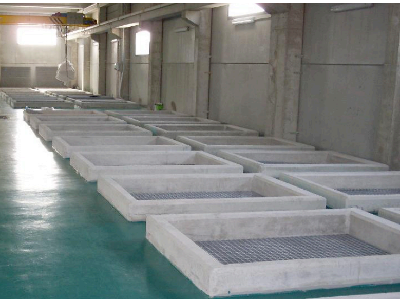
Remineralisation of SWRO Alicante II, Alicante, 80000 m 3 /d
