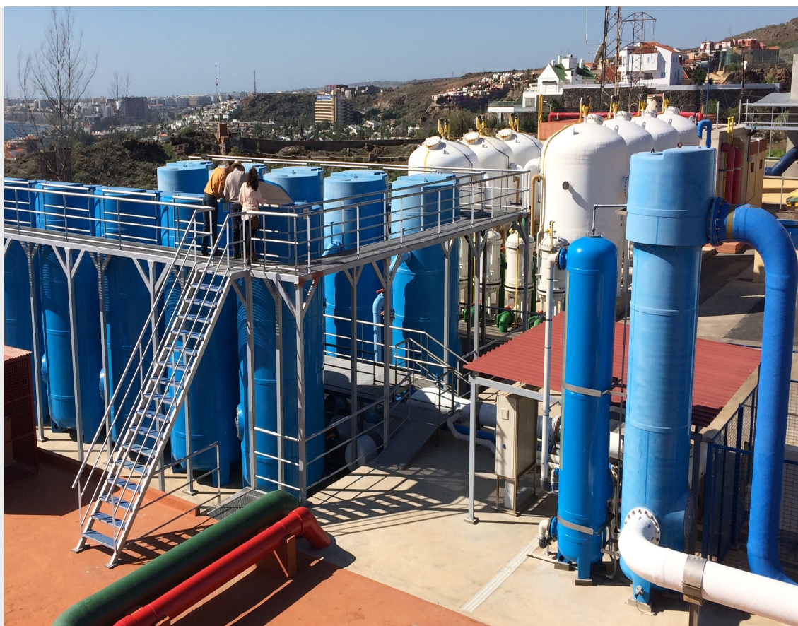
Fig. 1.3: Instalación de diez filtros de calcita DrinTec™ con disolver de CO 2 a baja presión
